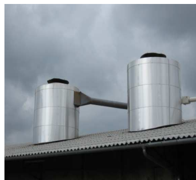
Traitement sur cyclone par calorifuge
